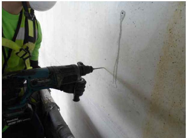
탄산화깊이 측정 현황
